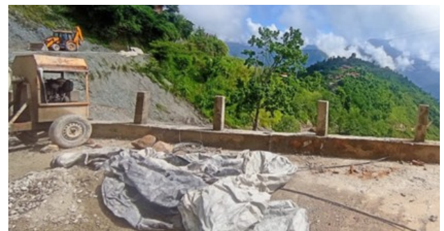
मुसिकोट दरबारको निर्माण स्थल
