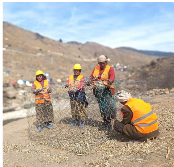
ग्याबियन संरचना निर्माणका लागि बाकस बुन्दै उपभोक्ता समितिका कामदारहरू
