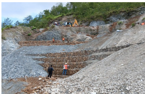
पहिरो नियन्त्रण संरचना निर्माण
