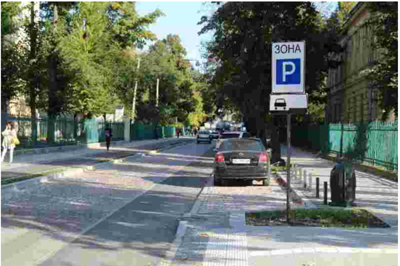
Фото 13: Буферна зона у Львові, велосипедна смуга з одного боку та зона облаштування/ благоустрою з іншого. Обидві забезпечують ефективне розмежування
