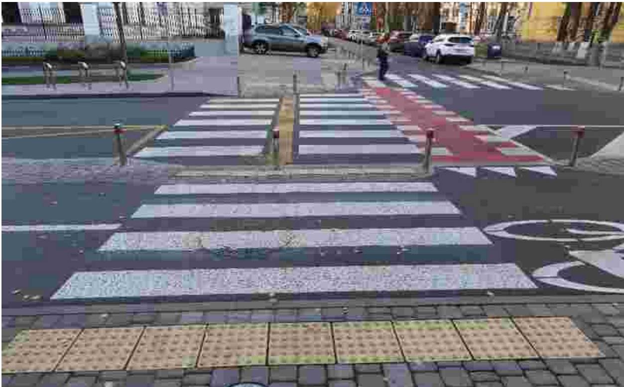
Фото 18: Пішохідний перехід з пониженням бордюром і тактильними індикаторами пішохідної зони (Увага! На фото антипаркувальний стовпчик посередині пішохідного переходу розташований з порушенням вимог пункту 8.2.2 ДБН В.2.2-40:2018 "Інклюзивність будівель і споруд" та пункту 10.2.14.5 ДСТУ 2587:2021 "Розмітка дорожня")
