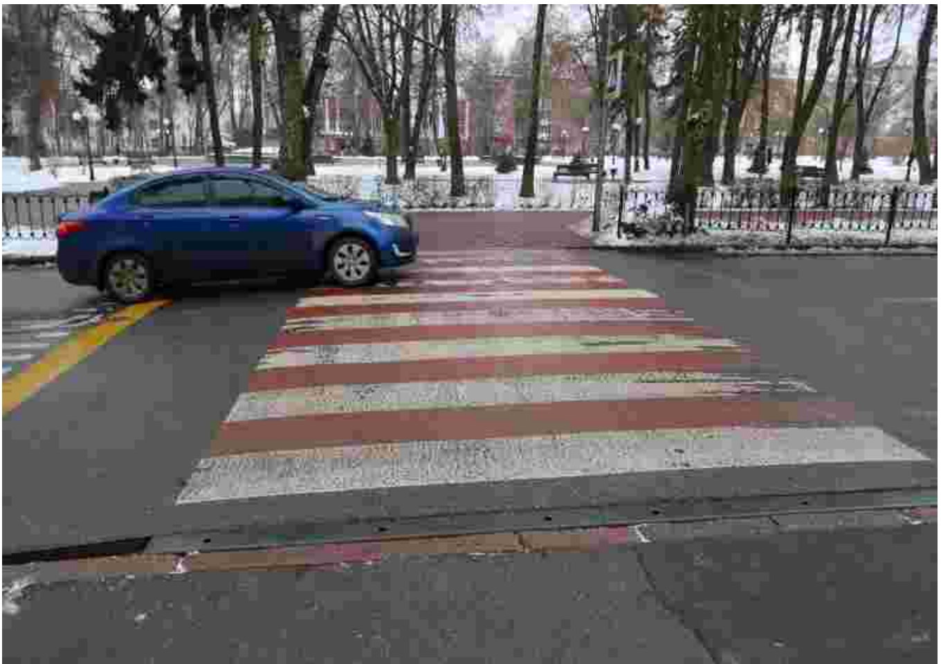
Фото 68: Плато швидкості (підвищений пішохідний перехід), Чернівці
