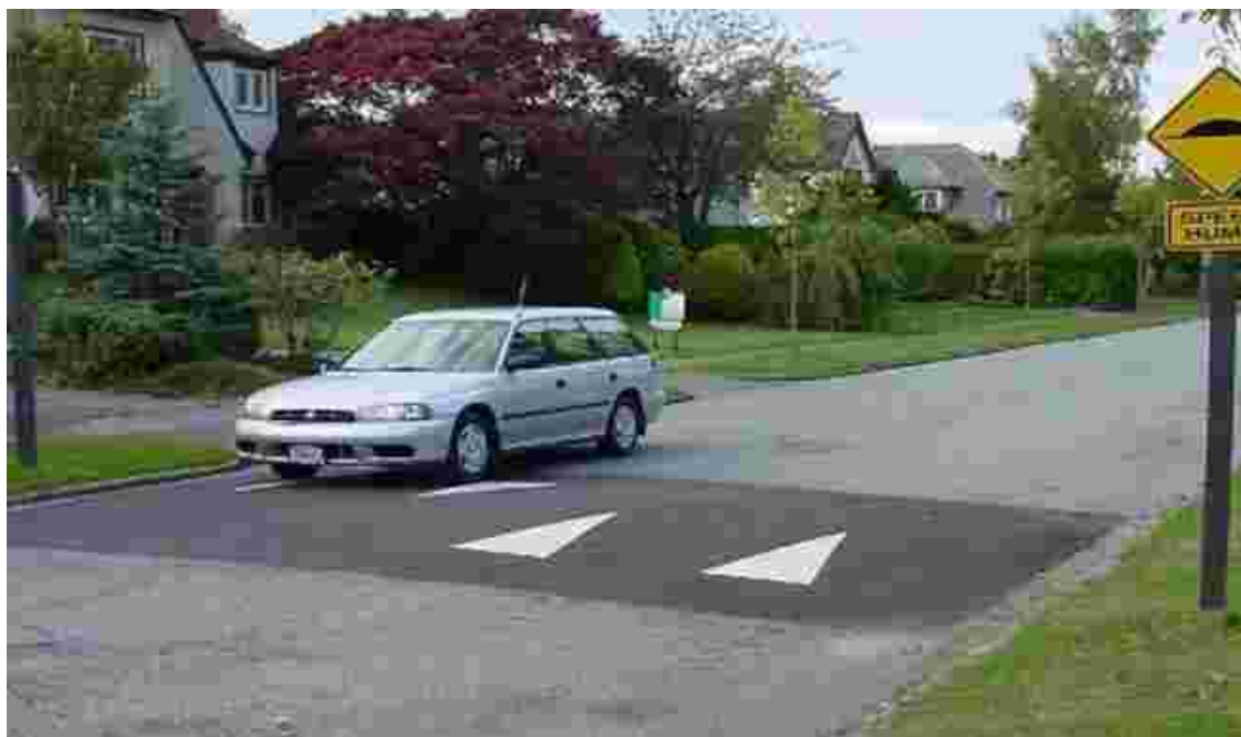
Фото 66: Дорожні пагорби, понижені у бортів до рівня проїзної частини, щоб уникнути змін у системі водовідведення
